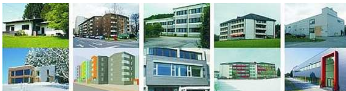
Przykłady modernizacji obiektów do wymagań standardów budownictwa pasywnego w Austrii
